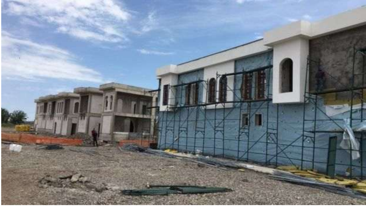
Diyarbakır Suriçi'nde inşa edilen yeni konutlar.
